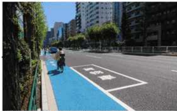
都道301号（白山通り） ※自転車通行帯の車道側に停車帯を設置
